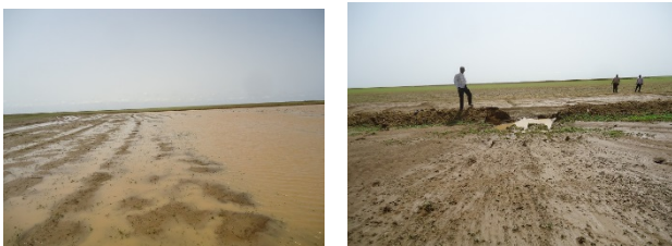
集水したジダアとはげしい水流で一部が破壊された土堤
