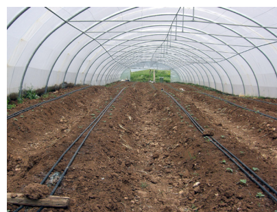
不均平な中でドリップ施設設置；定量の水を各ノズルから出すのがむずかしい。
