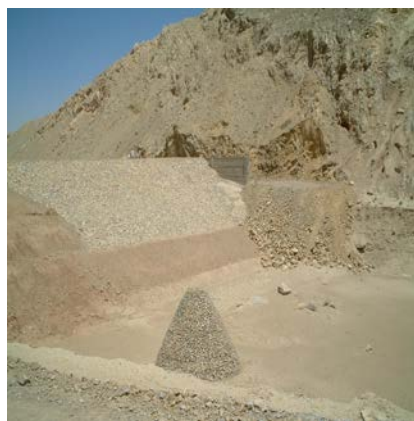
地下水涵養ダムの建設
