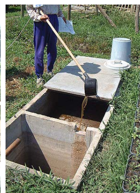
バイオガス液肥貯留槽
