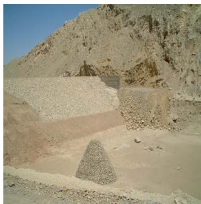
地下水涵養ダムの建設
