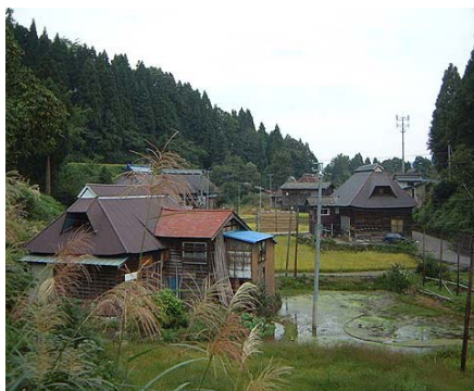
古民家(トタン屋根の下は茅葺き)
