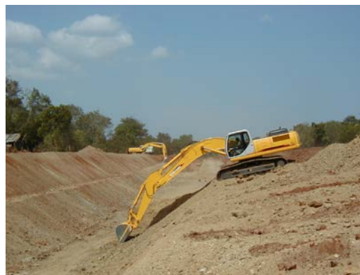
幹線 19km、支線 24km の水路工事
