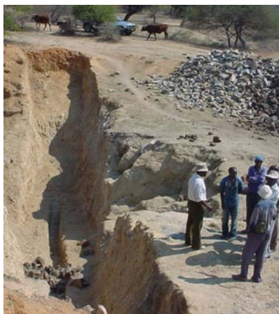
小規模ダムの補修工事現場
