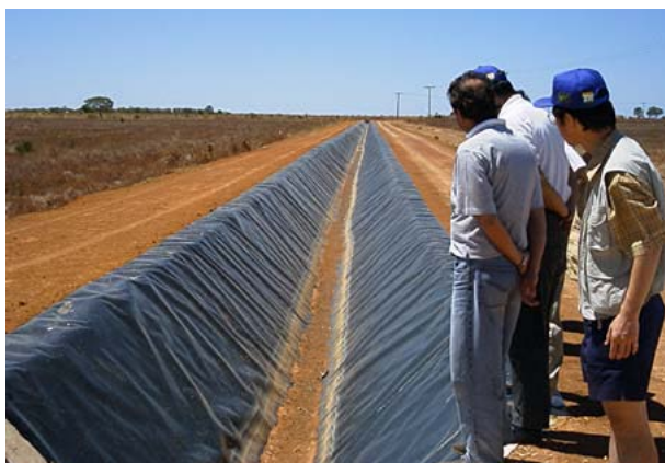
灌漑水路建設(ブラジル)
