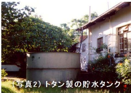
また、普段よく使う水の集水方法として、雨を直に屋根から集めてタンクへ貯水する方法がある。貯水タンクはトタンでできたもの（写真2）から、コンクリート、レンガを積んでモルタルで上塗りしたもの、木材、粘土でできているものまで様々なそれぞれの材料を用いて作られている。さらに湖沼、ワジ（＝枯れ川）、あるいは地下から直接ポンプで水をくみ上げて貯水タンクに集めることもできる。
