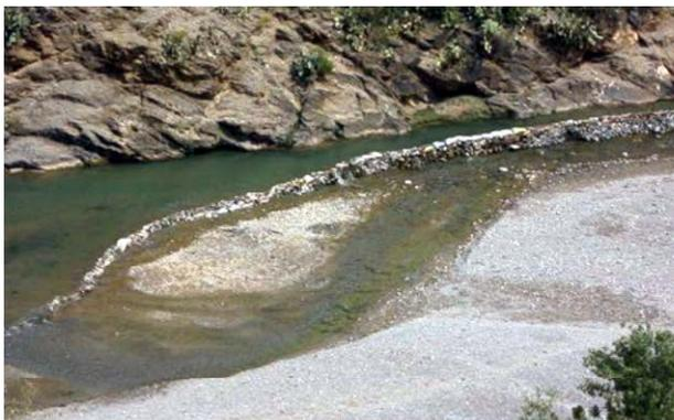
伝統的工法による小規模取水堰
