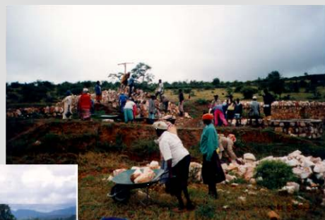
村人によるダム建設
