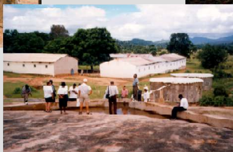
岩肌を利用した雨水集水施設 (後方の建物は小学校)
