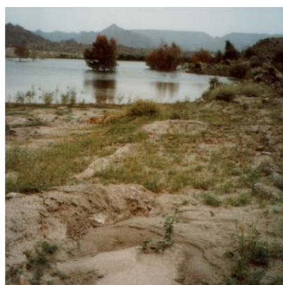
チェックダムによる雨水の貯留と 三日月型盛土による植林
