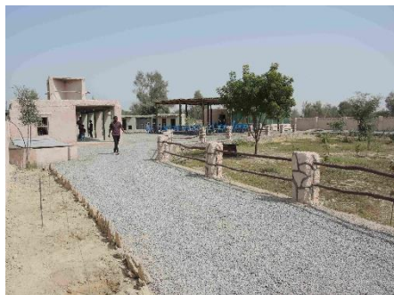
建設中の観光薬草園エントランス
