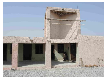
ゲシュム島の伝統的な採風・送風設備である Wind catcher
