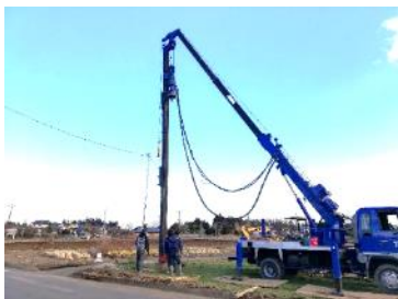
施設灌水や農薬散布に用いる水確保のため、借農地に井戸を掘削
