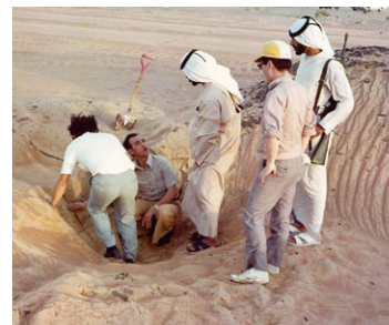
試験農場に敷設されたアスファルト止水盤を観察する先方政府の農業局長(1977年) The government's Agricultural Bureau Director observing the asphalt moisture barrier that was laid in the experimental station (1977)
