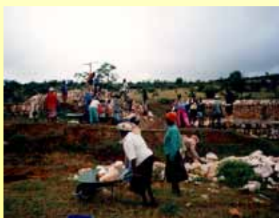
住民参加によるダム建設
