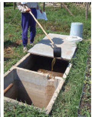
バイオガス液肥貯留槽
