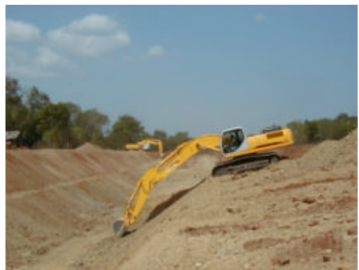
幹線 19km、支線 24km の水路工事
