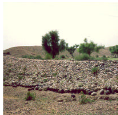
集水農業のための石積みの堰 (イラク)
