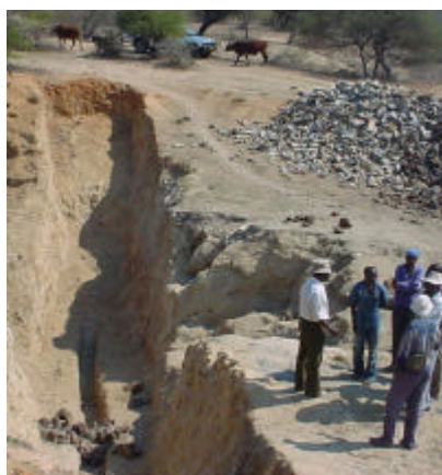
小規模ダム の補修工事現場
