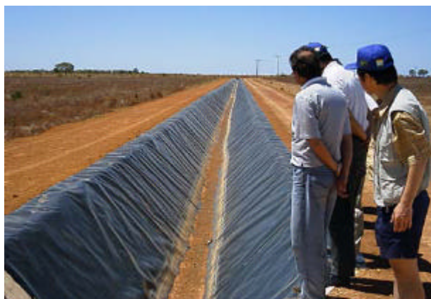
灌漑水路建設（ブラジル）
