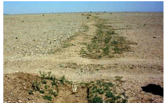
写真 天水確保用の簡単な溝
