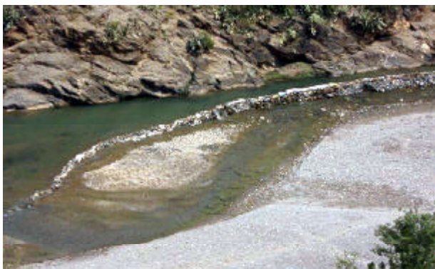
伝統的工法による小規模取水堰
